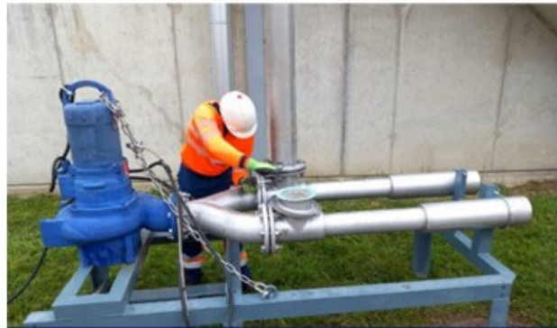
Mise en place du système d'aération secours de la station de traitement des eaux usées d'Etréchy
