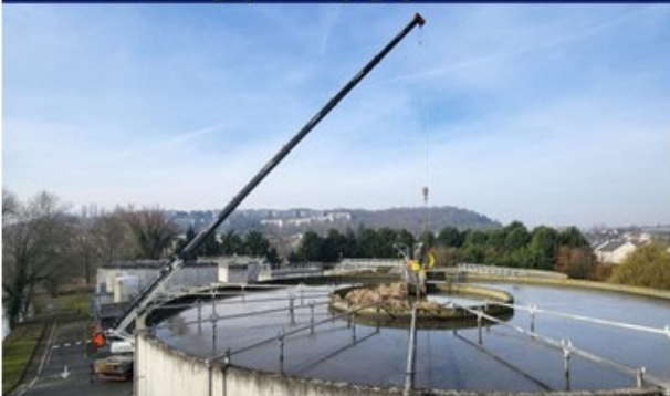
Renouvellement de l'agitateur du bassin d'aération de la station de traitement des eaux usées de Morigny-Champigny
