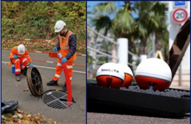
La SewerBall : Nouvelle technique d'investigation pour détecter les intrusions d'eaux claires parasites
