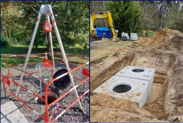
STEU Etréchy : Mise en place du système d'aération secours
