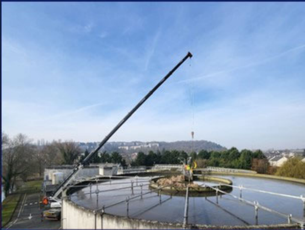
STEU Morigny-Champigny : Renouvellement de l'agitateur du bassin d'aération
