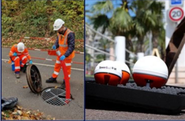
La SewerBall : Nouvelle technique d'investigation pour détecter les intrusions d'eaux claires parasites
