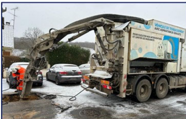
Réparation d'une fuite à l'aspiratrice sur Etréchy
