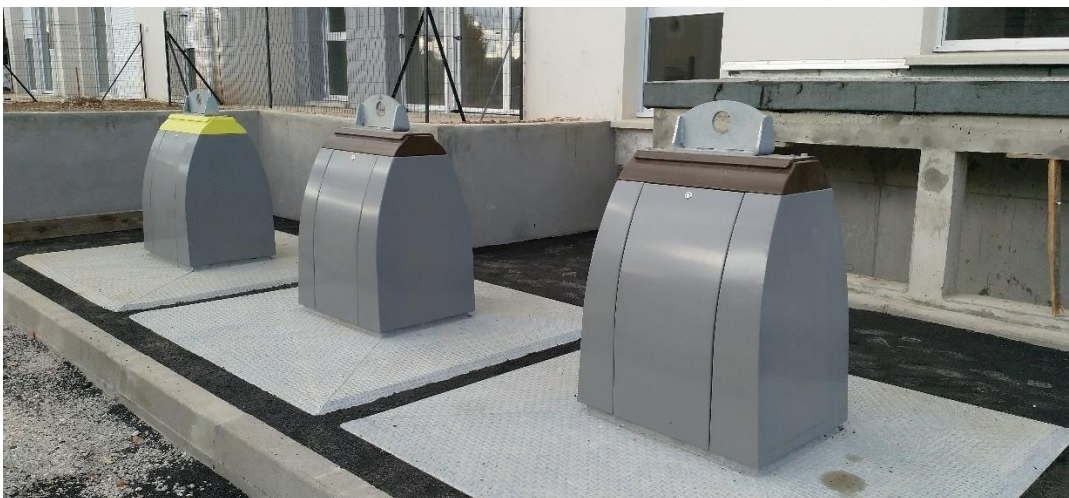
Figure 5 : bornes enterrées à Angerville
