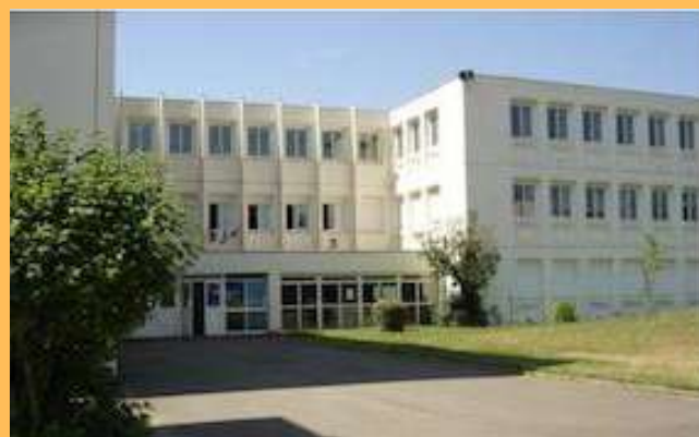
Façade avant les travaux
