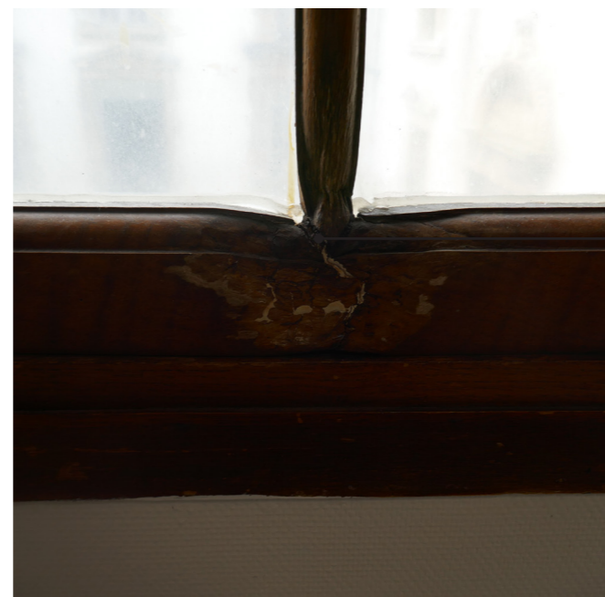
Bois en mauvais état (mérulle ?) sur les fenêtres A-F16 et A-F17
