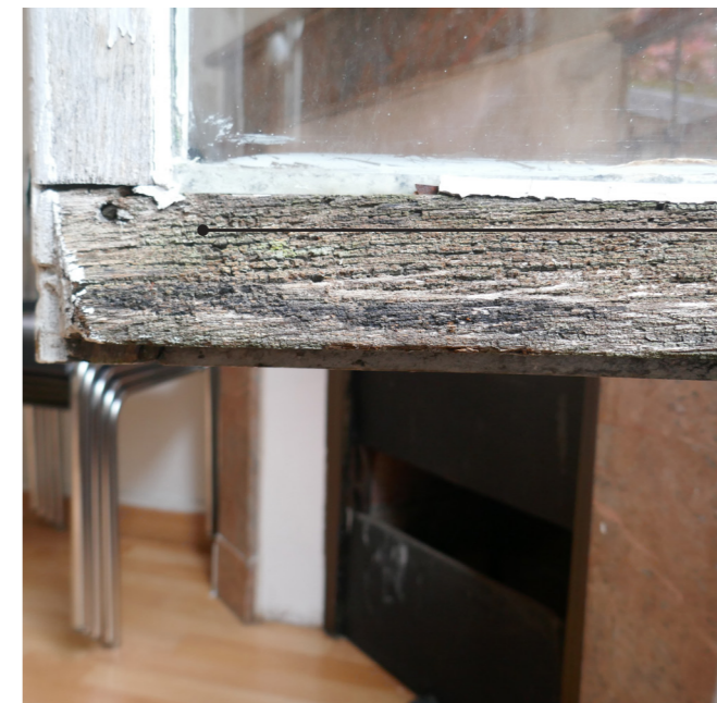
Type 6 (fenêtres des bât autour de la courette)
