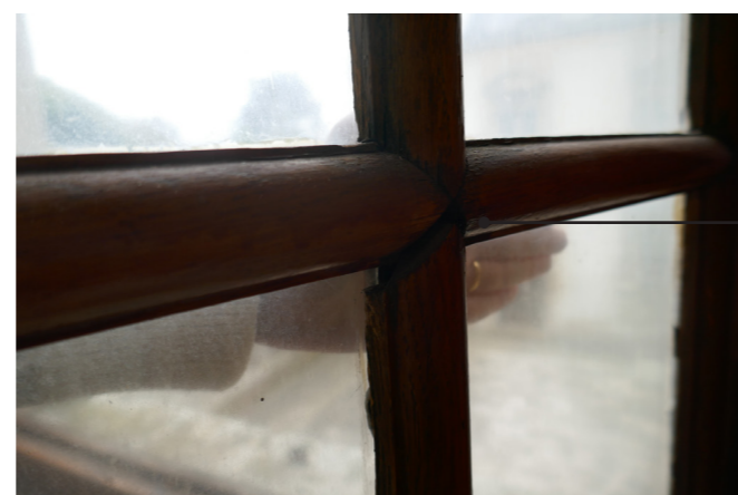
Loqueteau non fonctionnel (maintenus par un élastique)
