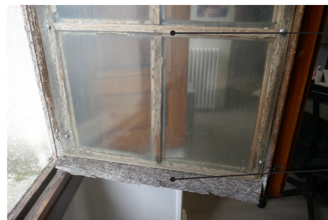
Cordon mastic en mauvais état
