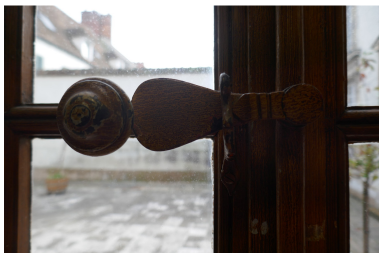
Loqueteaux à ressort pour volets intérieurs (1) et pour ouvrants (2)
