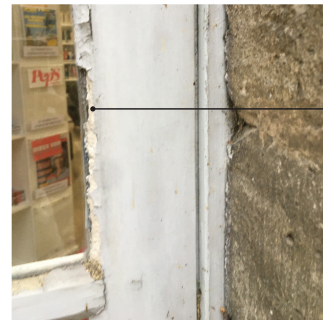
Bois en mauvais état (mérulle ?) sur les fenêtres A-F16 et A-F17
