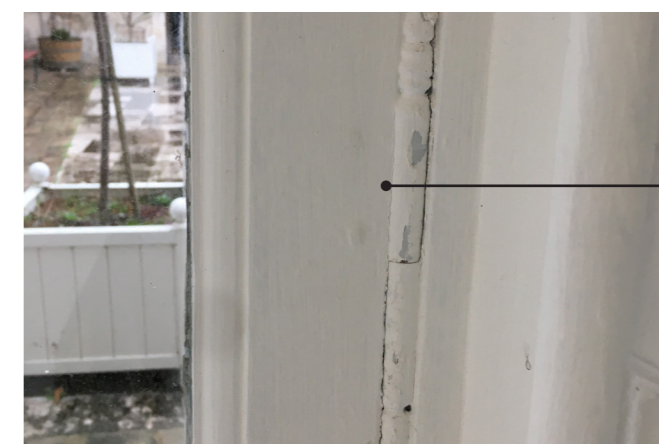
Assemblage bois en mauvais état
