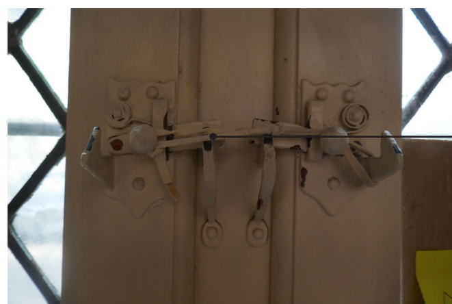
Loqueteau non fonctionnel (maintenus par un élastique)
