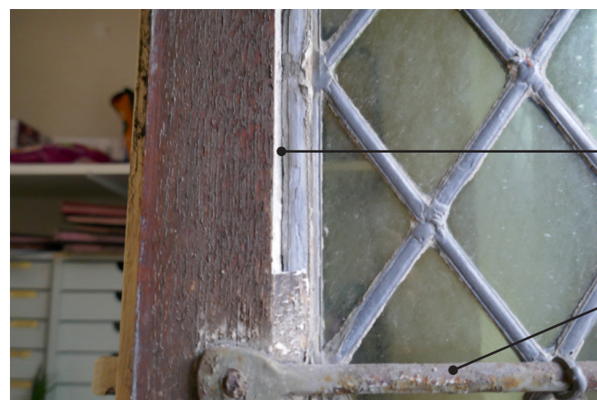
Cordon mastic en mauvais état
