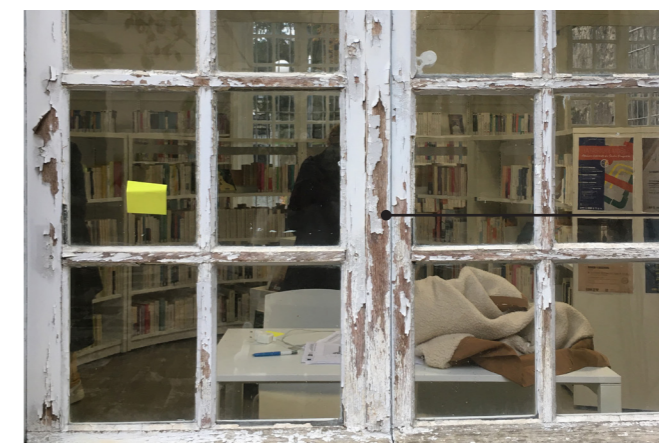
Planche de plexiglass clouée pour protéger des chutes de verres (fenêtres A-F15 à A-F17)
